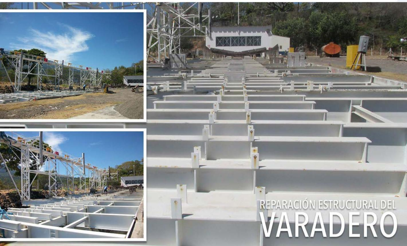
Consistió en la reparación del carro de varada, el cual es una estructura a base de perfiles de acero laminado diseñado para recibir buques de 1,750 toneladas.
