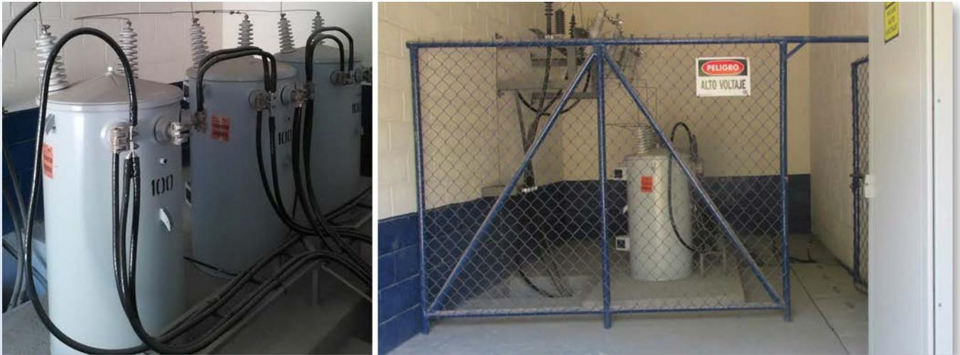
La nueva sub-estación construida posee una capacidad 300 KVA y está formada por un banco de tres transformadores monofásicos de 100 KVA.
