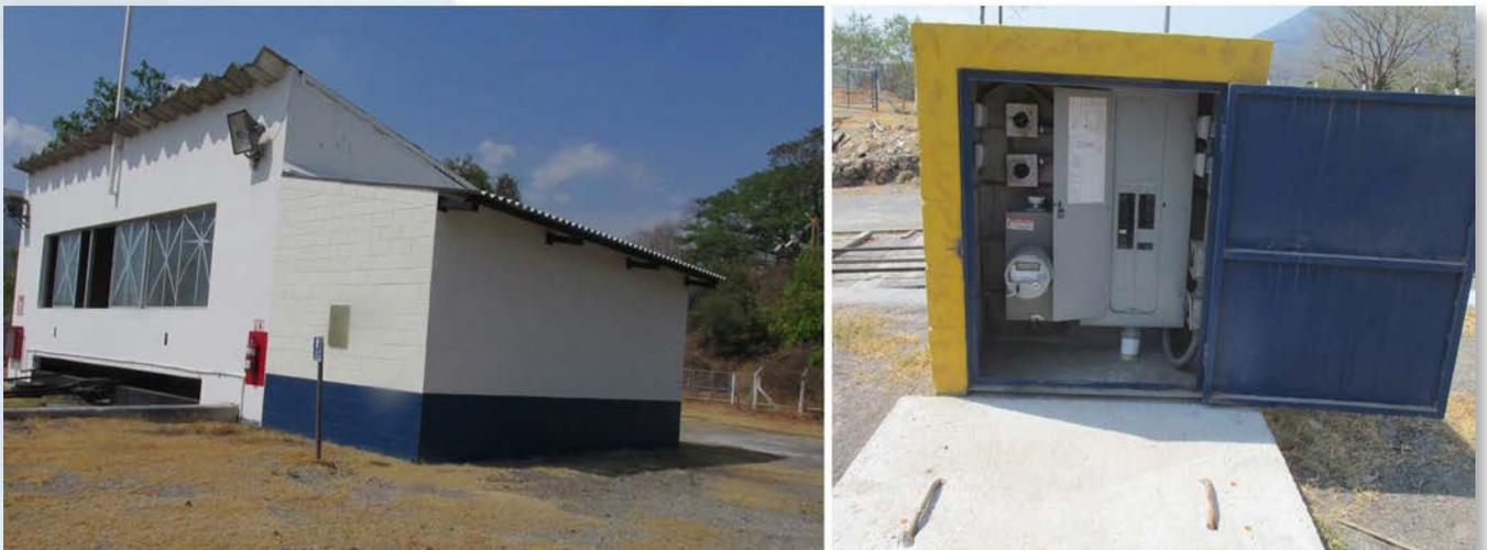
Construcción de la caseta para albergar la nueva subestación eléctrica, cajas para alojamiento de tableros y de registro, canalizaciones para cables de potencia y de distribución secundarios.
