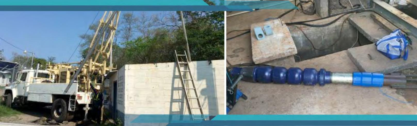
Se realizó mantenimiento de pozo y bomba, con el propósito de mantener en óptimas condiciones la bomba para extracción de agua que brinda el suministro de las instalaciones portuarias.
