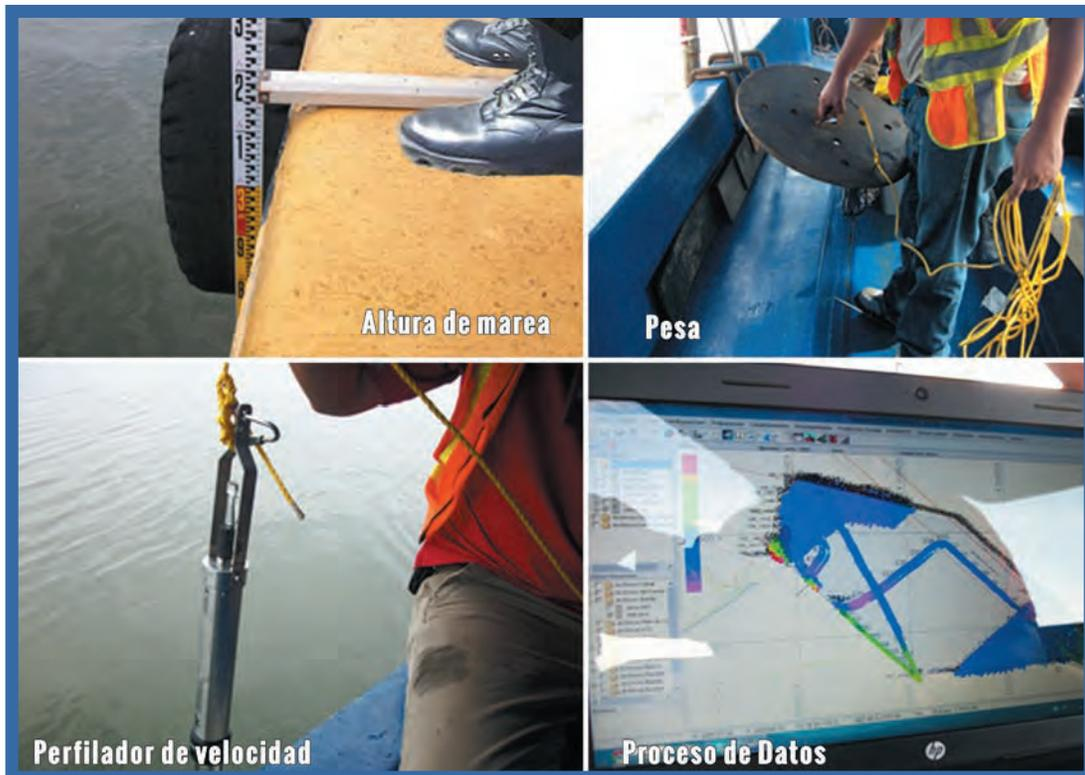
En el año 2014, se realizó el estudio técnico de batimetría mediante el proceso de Libre Gestión, del cual se obtuvo el volumen de azolve el cual servirá de base para un dragado y mantenimiento de la profundidad necesaria para el atraque de las embarcaciones.
